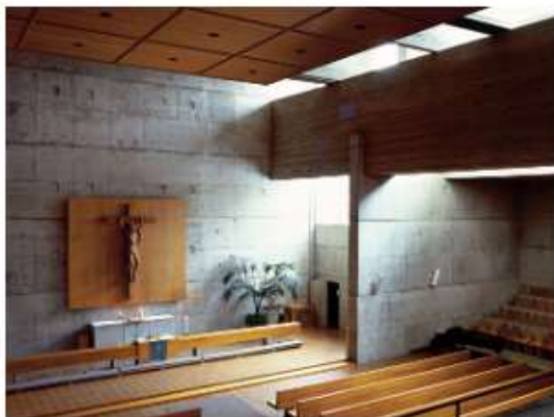
Kirkkosalin seinäpinta on sileäksi hierrettyä betonia. Soile Tirilä .
